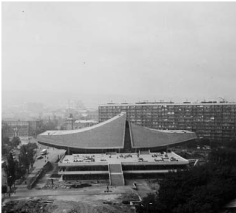
"Rusya" Sineması inşaatı (70'lerin başı)
