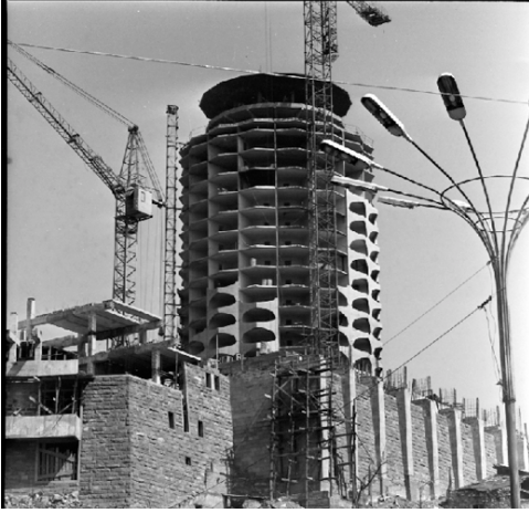
Yerevan'daki Gençlik Sarayı'nın inşası
